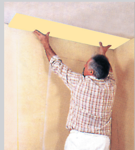
UNIVERSAL-Dämmkeil für Deckenzone und einbindende Innenwand
