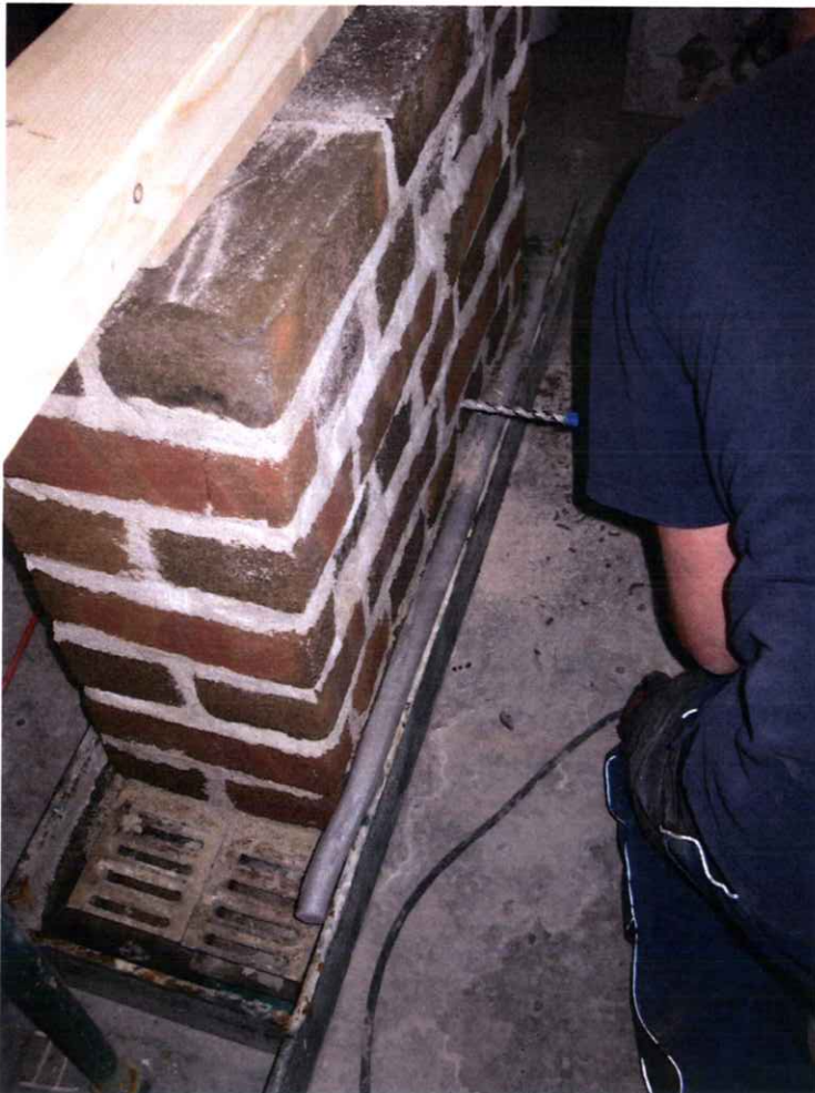
Bild 2: Bohren der Injektionskanäle
