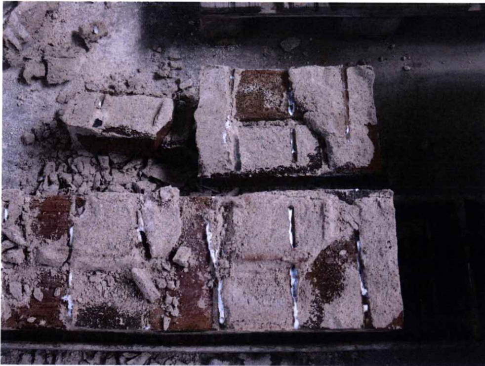
Bild 5: Demontage des Prüfkörpers in Höhe der Injektionsebene
