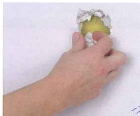
Entfernen Sie das losere und brüchige Material am Rand der zu schließenden Öffnung.
