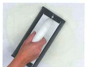
Nach dem vollständigen Trocknen der Spachtelschicht schleifen Sie die Fläche gegebenenfalls nach. Sie haben nun eine glatte und besonders ebene Oberfläche für die Endbeschichtung Ihrer Wahl.
