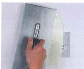
Tragen Sie die erste Schicht Spachtelmasse auf und ziehen Sie die Masse gut aus. Falls erforderlich, ziehen Sie nach erfolgter Trocknung eine zweite Schicht Spachtelmasse auf.
