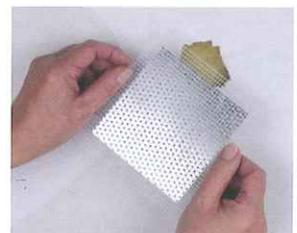
Kleben Sie das Reparaturgewebe mittig über die zu schließende Öffnung.
