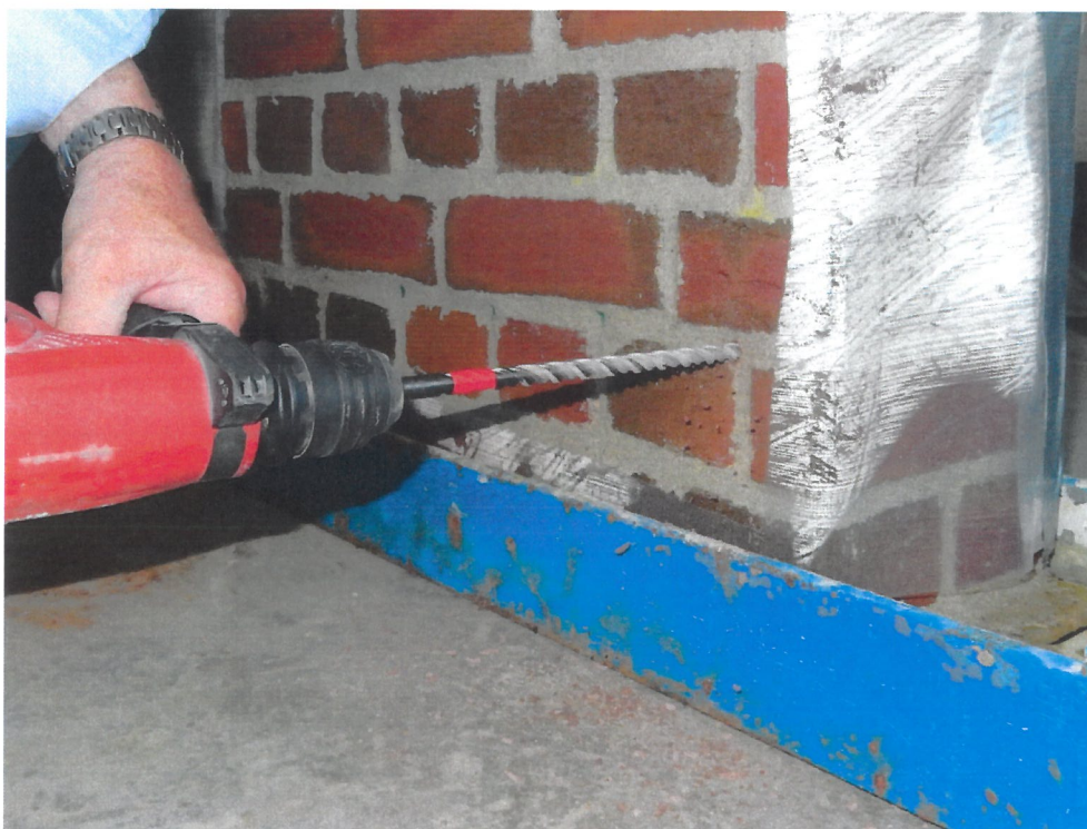
Bild 1 Anlegen der Bohrungen
