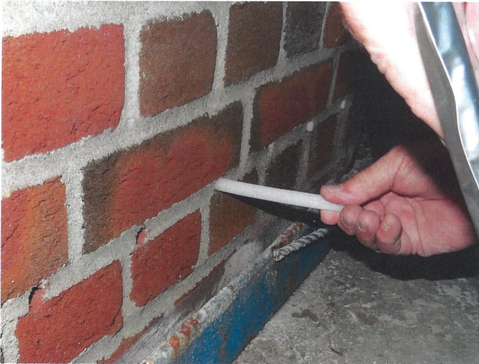
Bild 3 Einschieben der Secco Horizontalsperren-Sticks
