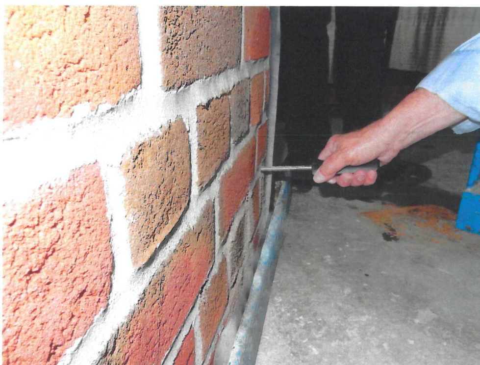
Bild 2 Reinigung der Bohrlöcher
