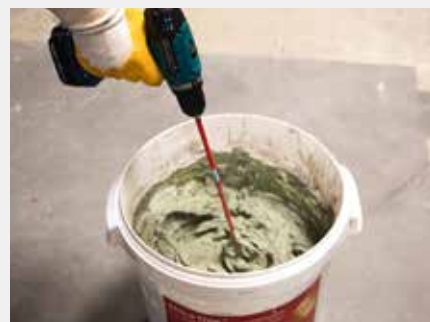
▲ 3. Anrühren Secco One Flüssig- und Pulverkomponente miteinander verrühren
