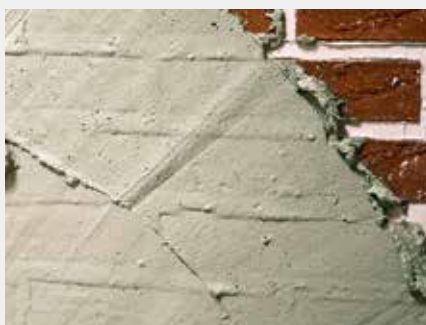
▲ 4b Auftragen mit einer Glättkelle
