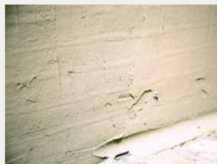
▲ 5. Hohlkehle bilden Anschluss zwischen Wand und Boden mittels Hohlkehle herstellen
