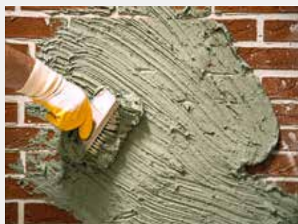
▲ 4a Auftragen mittels Quast
