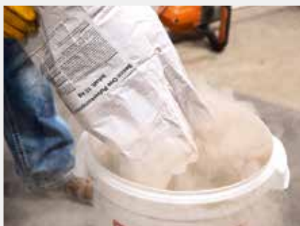
▲ 2. Mischen Secco One Pulverkomponente hinzufügen
