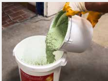
▲ 1. Einfüllen Secco One Flüssigkomponente in den Mischeimer geben
