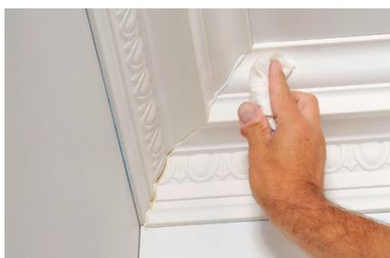
**ADEFIX®PLUS** für die Verklebung von Stoßfugen und Gehrungen bei **WALLSTYL®** und **ARSTYL®** Profilen ab einer von Ausladung 10 cm
